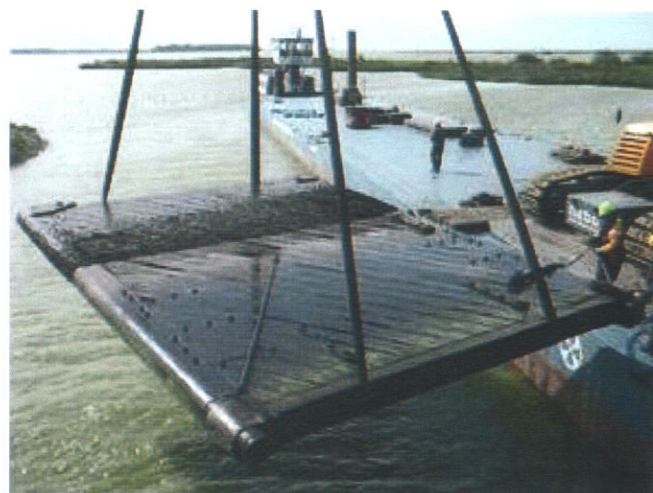
De gigantische sluisdeuren van het Wouda-gemaal werden enkele weken geleden al verwijderd en naar Kampen vervoerd. foto Wijma
