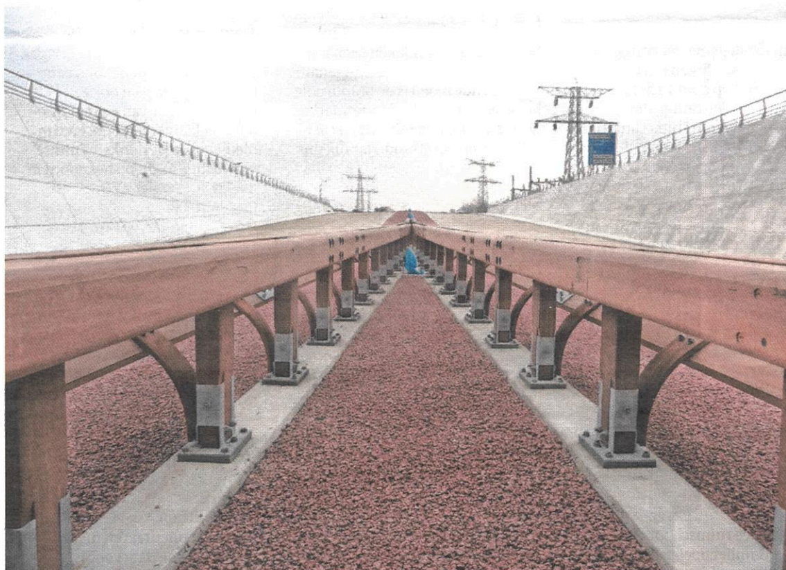
Houten geleiderails scoren op veel technische onderdelen even goed als staal of zelfs beter. Foto: Centrum Hout
